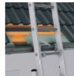
Scala portatile a pioli vincolata nella zona di sbarco
