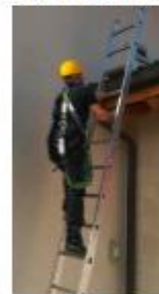
Scala portatile a pioli vincolata nella zona di sbarco
